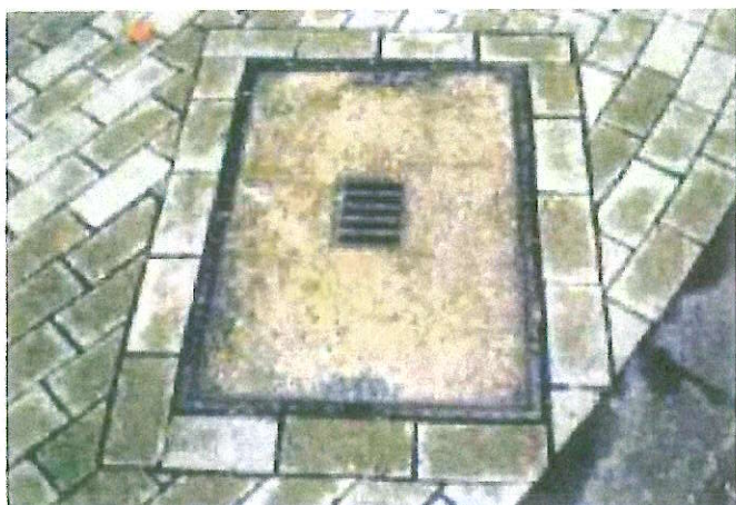
Abbildung 5: Umpflasterung von Einbauten
