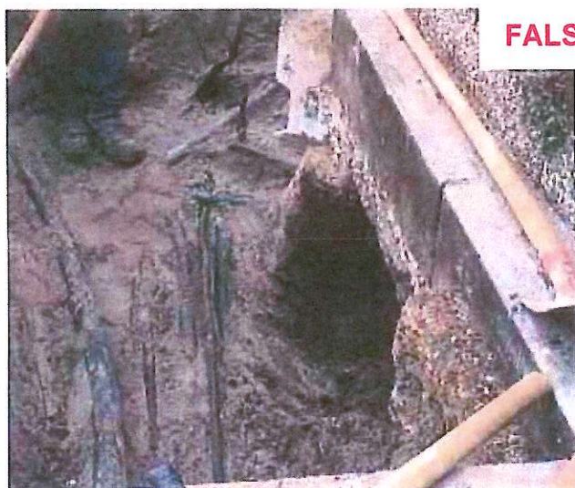
Abbildung 6: Negativbeispiele Unterhöhung von Randeinfassungen
